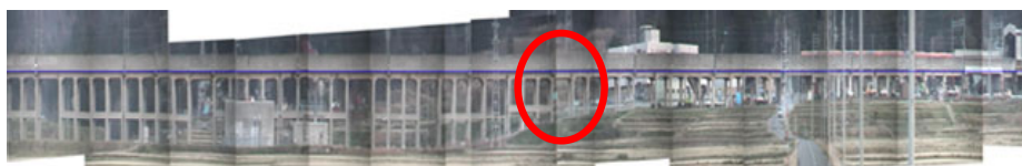
図10 著大相対変位発生箇所206km285m付近(印)
