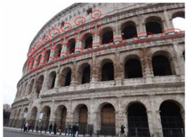
図 #40周辺に設置されたファスナー(赤丸内) Figure: Fasteners around #40
