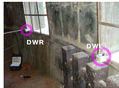
写真3 大仏内背面窓での測定
