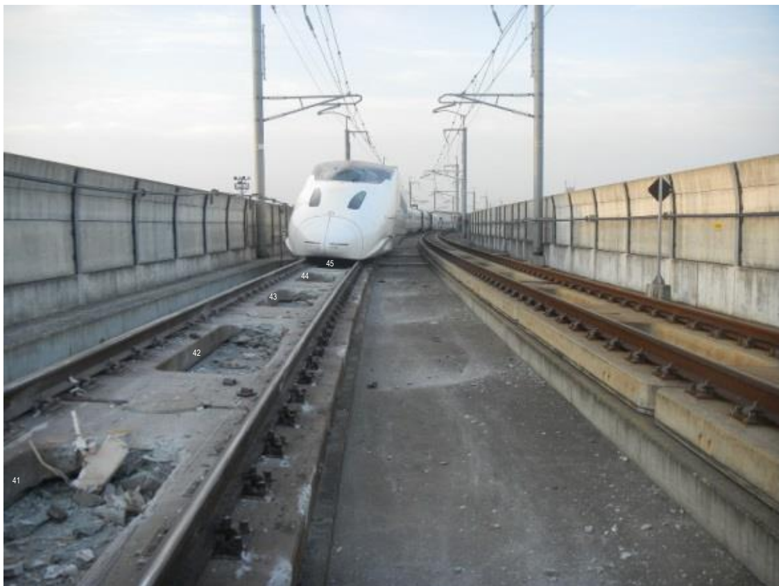
写真 C：脱線車両最後尾車両の後の軌道状況（国交省）
